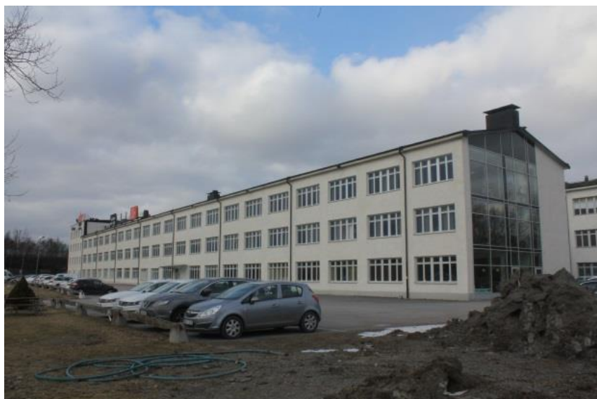
Foto 1. Fastigheten sedd från norr.
